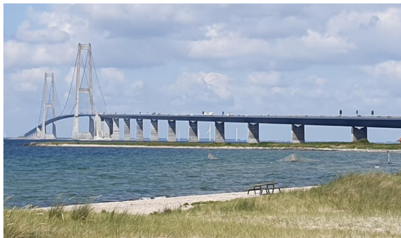
Blick auf die Brücke Großer Belt
